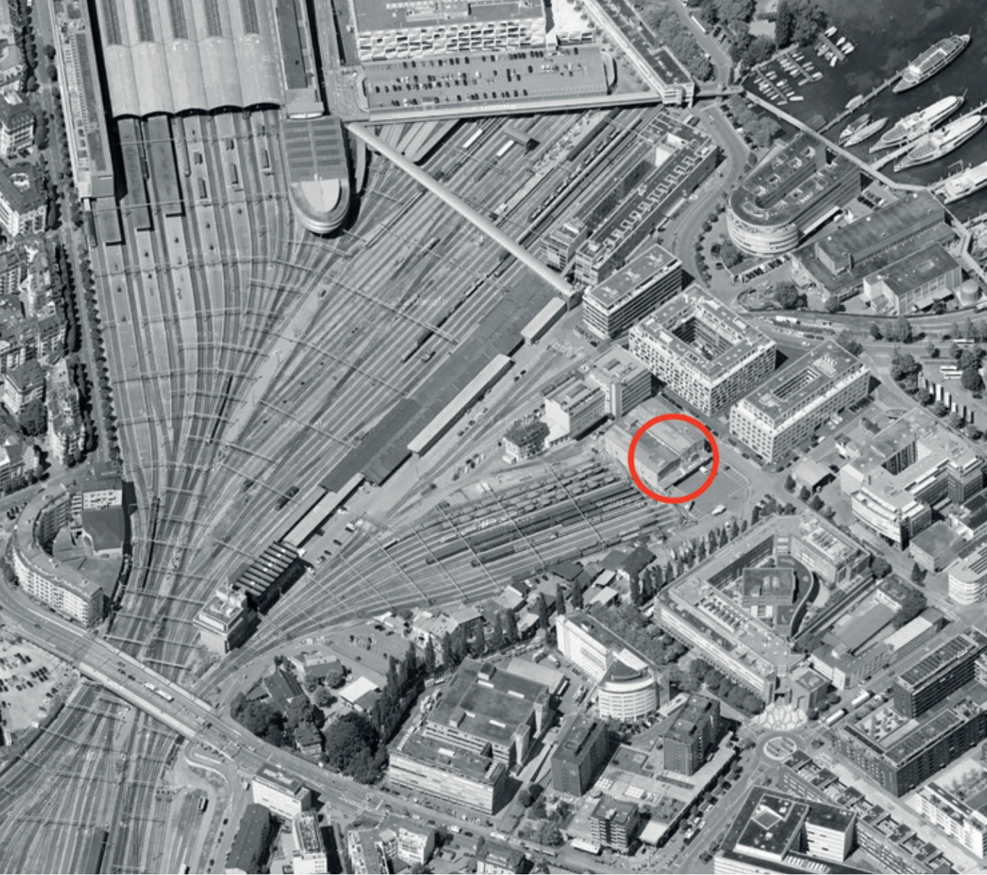
Luftbild Areal Rösslimatt
